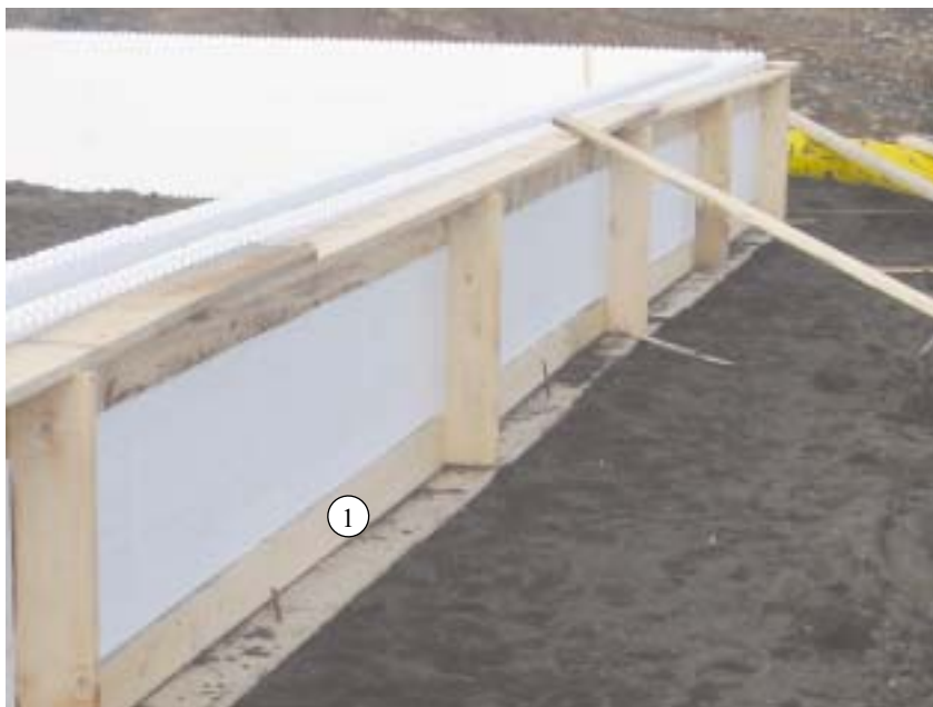
Stuðningur við sökkuluppslátt.
