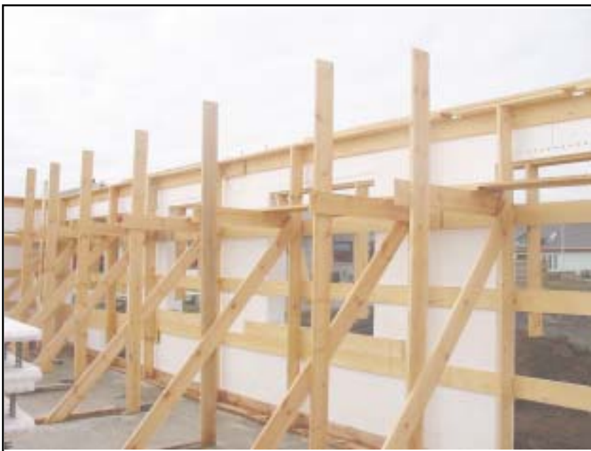
Stuðningur við vegg-uppslátt 2.huti (stillas að innanverðu).
