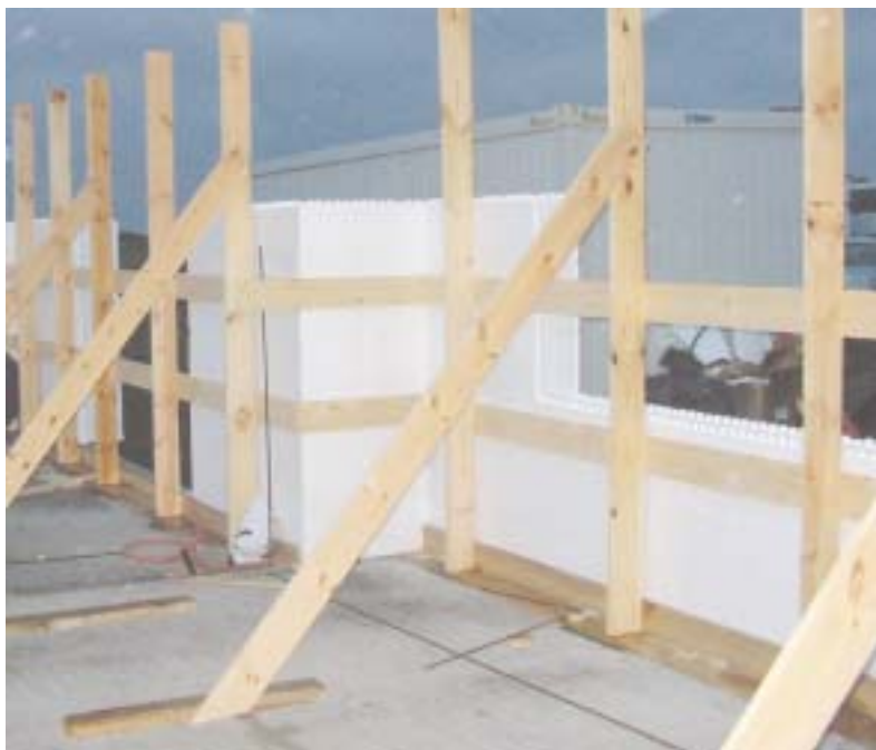
Stuðningur við vegg-uppslátt 1.hluti (að innanverðu).
