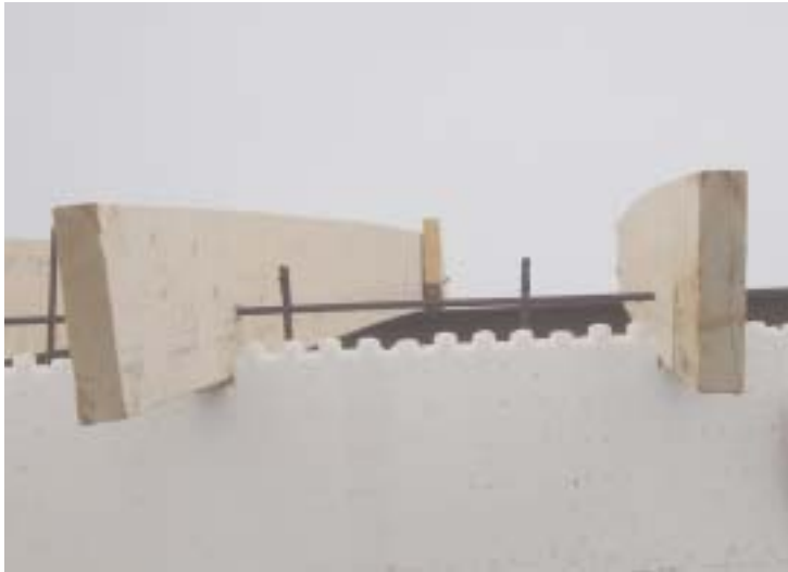
Borað fyrir járntein í sperrurnar.
