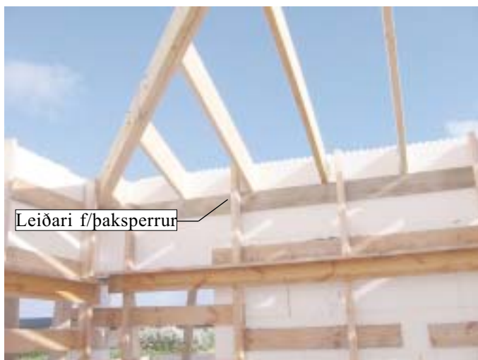
Þaksperrum komið fyrir.
